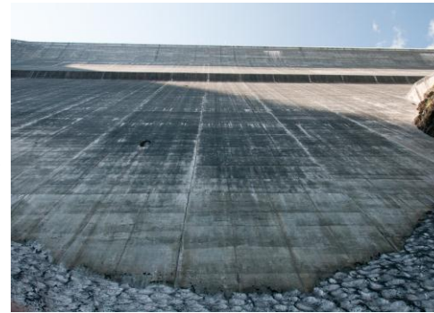
Interface roche-béton d'un barrage
